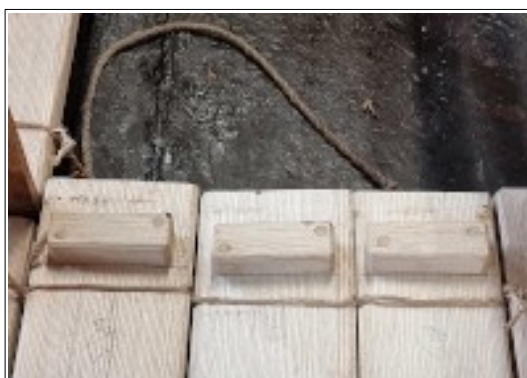
Fig. 15: Skridlåse. Asketræs klodser limet til dæksbrættet og sikret med dyuler.
