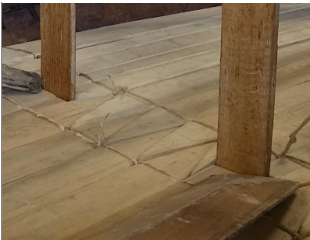
Fig. 14: Et eksempel på en færdig sammenfletning af dæksbrædder
