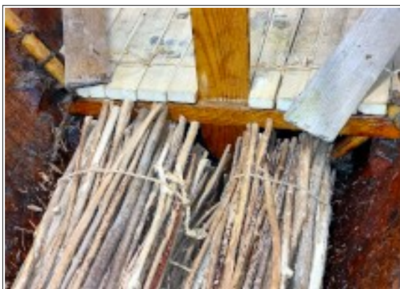
Fig. 22: Risbundter som fødstøtte
