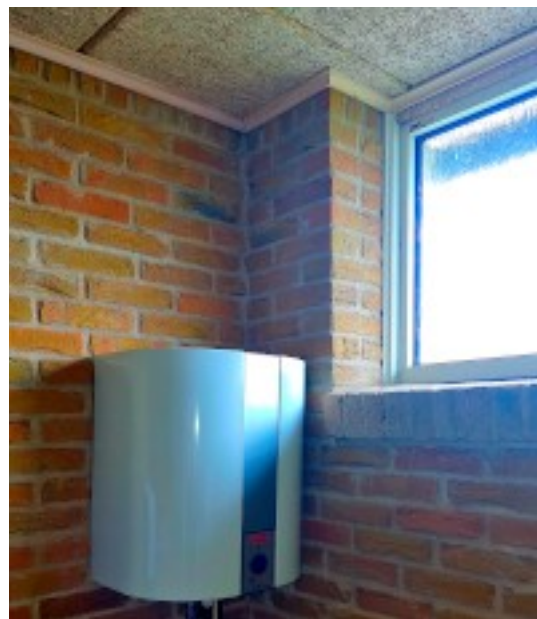
Hulkehl ved loft / væg hele vejen rundt på toilettet, samt afslutning ved vinduet.
