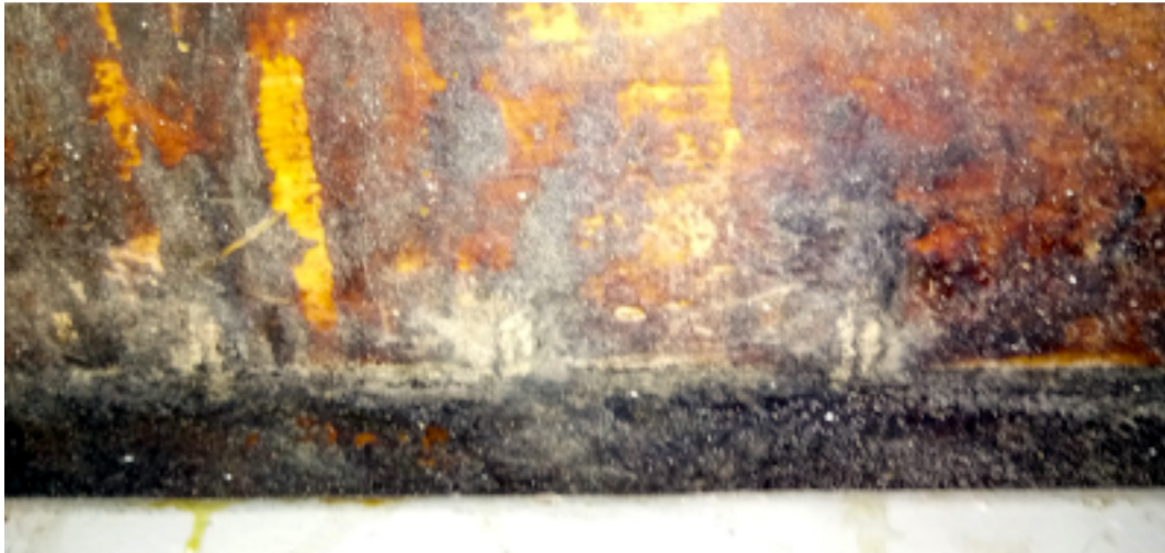
Fig. 9: Hvor de permanente bærestropper har været anbragt.
