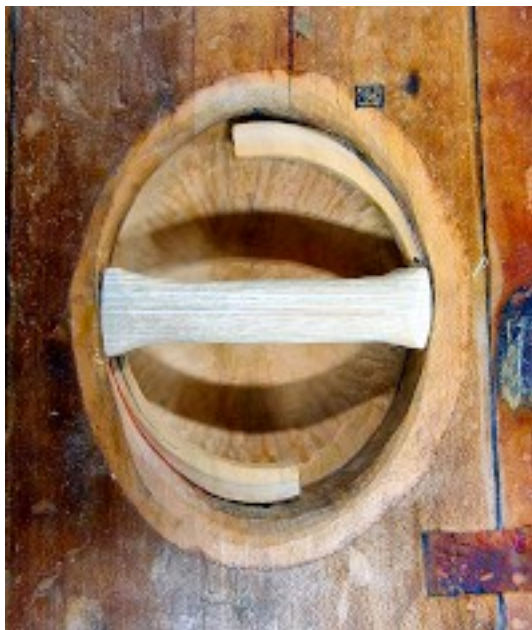
Illustration 28: Greb isat og de to låse placeret.
